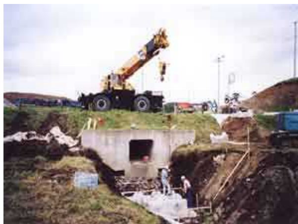
↑発注 釧路土木現業所 工種 根固ブロック工
